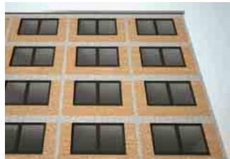
Der alte Baukörper mit einer Bestandsfassade in ausgefachter Stahlbeton-Skelettstruktur.
