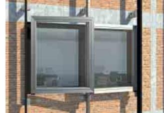
Die neuen Fensterelemente werden auf der Innenseite der Traglisene montiert, während die alten Fenster vorerst in der Fassade verbleiben.
