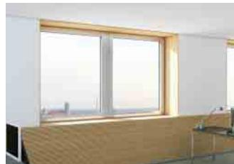
Nach Fertigstellung der Außenseite werden die alten Fensterelemente auf der Innenseite demontiert. Die Laibungen werden zum Beispiel mit Plattenelementen aus Holz, Blech oder Gipskarton verkleidet.
