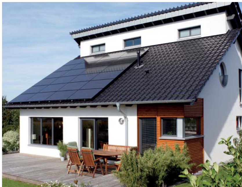
Bolighus med solceller på taket
